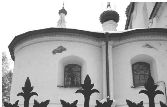
Рис. 6. Церковь Ильи Пророка в Ярославле (XVII в.). Растёсаны новые оконные проемы взамен первоначальных, следы которых открыты и сохранены реставраторами
