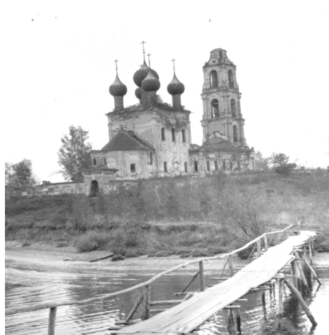
Рис. 4. Церковь Троицы (XVIII в.) в селе Диево-Городище. Шпиль колокольни разрушен в результате попадания молнии
